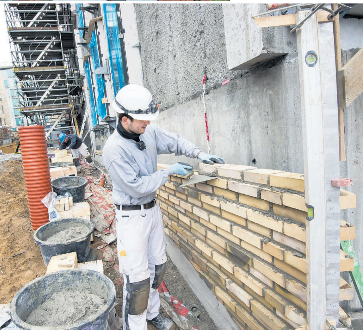
Murer Mathias Madsen i gang med at skalmure en af de boligstænger, der strækker sig ned mod parken og åen. Foto: Axel Schütt
